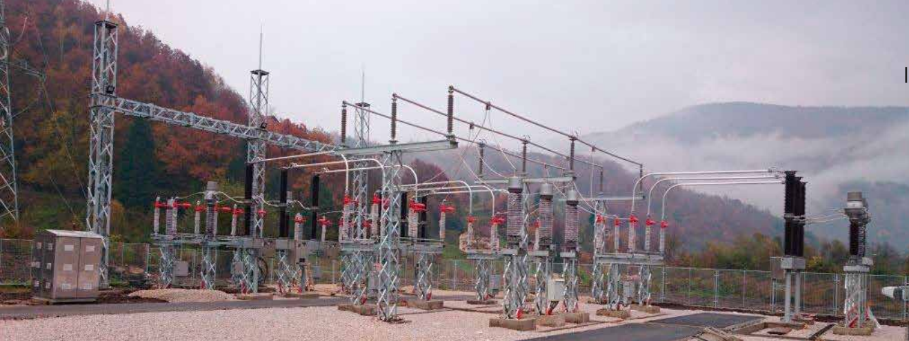
TS Fojnica – završeni svi planirani radovi u vanjskom postrojenju
