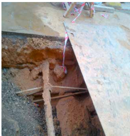
Slika 18. Kanalizacija za stambenu zgradu
