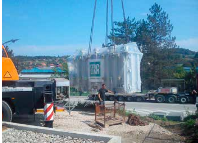
Istovar novog transformatora T2 110/10/35 kV u TS Tešanj
