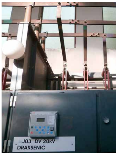
Слика 1. Замјена заштита у ТС Дубица
