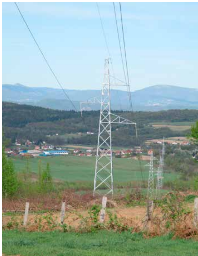
DV 110 kV TS Visoko – TS Fojnica
