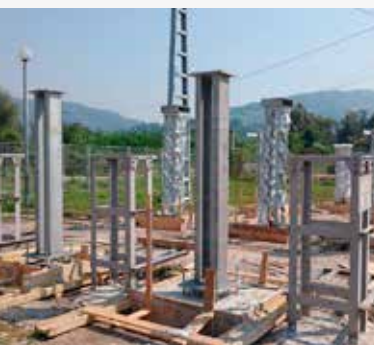
Postavljanje čeličnih konstrukcija u DV polju 110 kV Vitez
