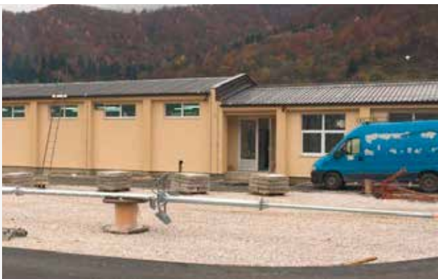
Priprema konstrukcije za vanjsku rasvjetu
