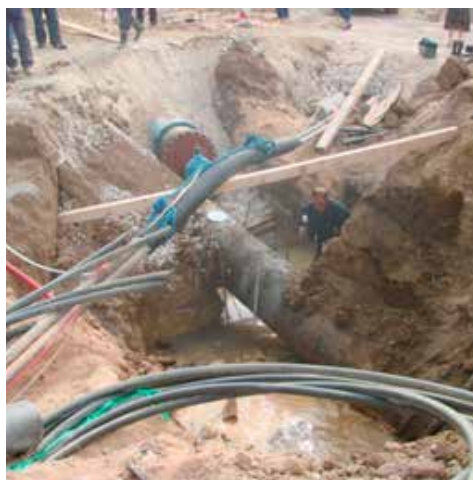
Slika 23. Izgradnja kružnog toka
