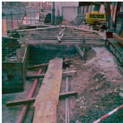
Slika 21. Izgradnja temelja za most
