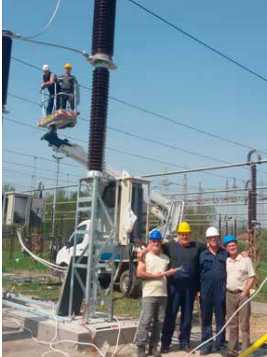
Zamjena prekidača 220 kV (Zaposlenici TJ Tuzla: Salih Kopić, Omer Burgić, Jasmin Husić i Sead Huskić)
