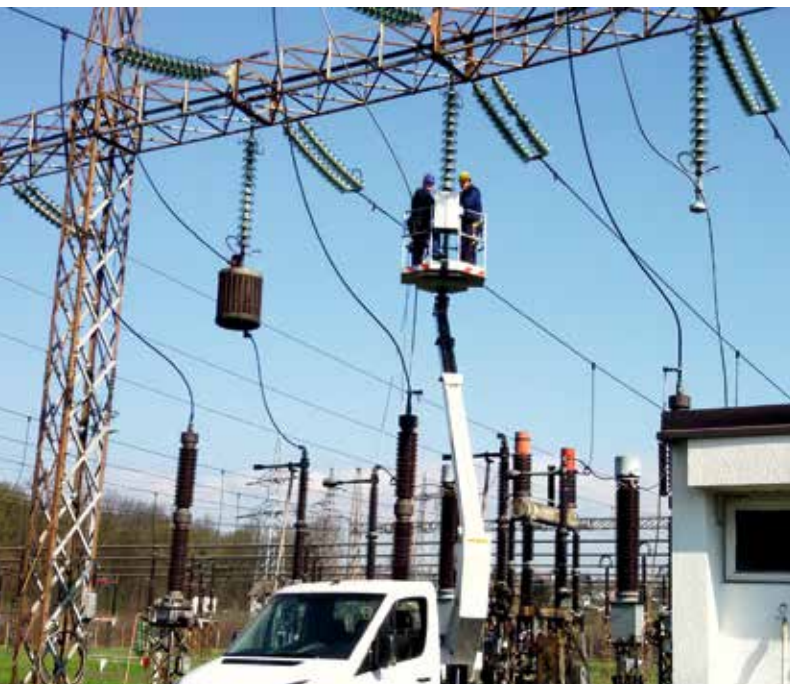
Kruto prespajanje prekidača u DV polju 220 kV Zenica'
