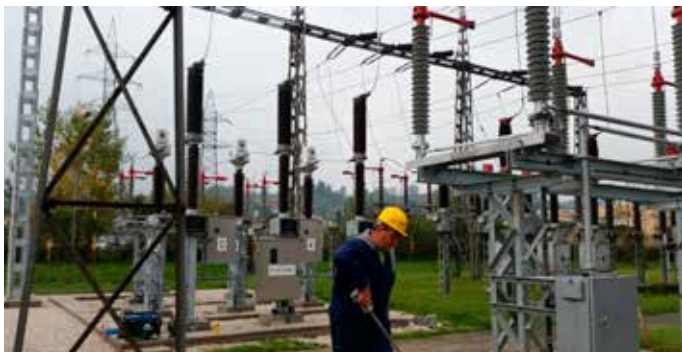
DV polje 110 kV Fojnica u TS Visoko
