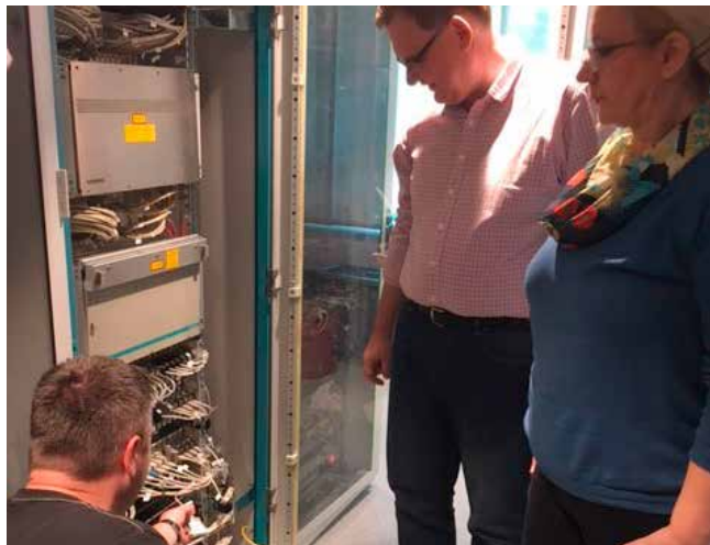
Telekomunikacioni ormar sa serijskim RS 232 koncentratorima i GSM modemima Enisa Kurtović (vođa projekta) – iz Službe za obračunsko mjerenje Nermin Isović i Sead Bećirović – iz Službe za telekomunikacije
