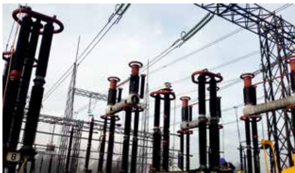
Demontaža prekidača 400 kV
