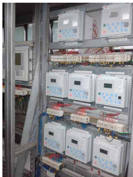
Слика 2. Замјена заштита у ТС Бања Лука 3
