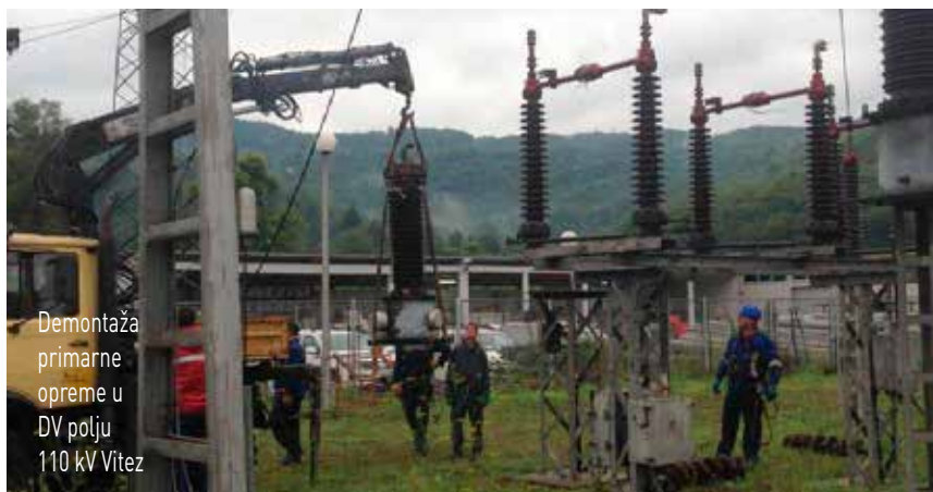
Izgled trafo-polja 110 kV transformatora T1 prije rekonstrukcije i proširenja TS
