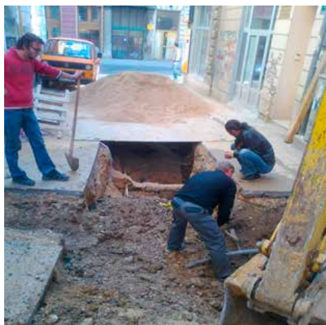
Slika 19. Kanalizacija za stambenu zgradu
