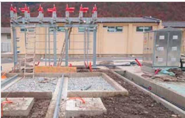
Završni radovi na pripremi za ugradnju energetskog transformatora
