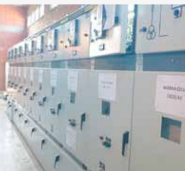
Novo postrojenje 20 kV unutrašnje montaže
