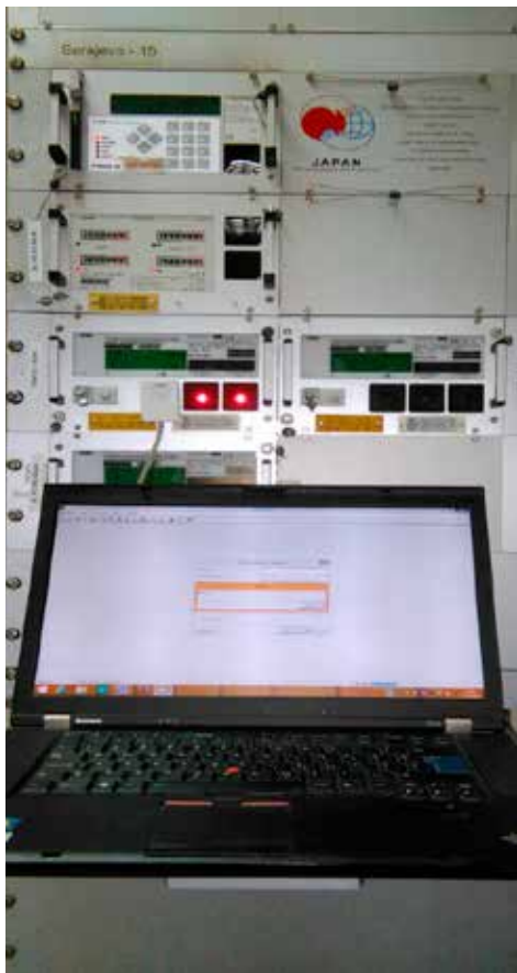
Ormar mjerenja TS Sarajevo 15 Konfiguracija parametara multifunkcijskog brojila MT860 na terenu
